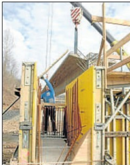
Bahn frei: Ein Arbeiter räumt eine Bohle weg, während der Träger heranschwebt.
