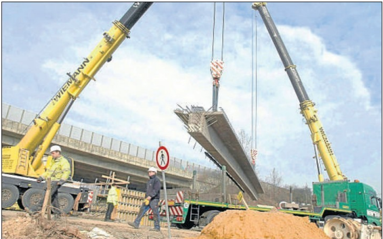
46 Tonnen Beton und Stahl am Haken: Die Kranführer haben den 24 Meter langen sogenannten Stahlbetonbinder sicher am Haken. Langsam schwenken sie ihn Richtung Autobahnbrücke (links) und setzen ihn auf dem Widerlager ab. Fotos: Dilling
